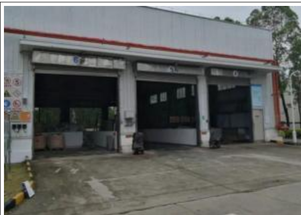
危废间门口 已设置漫坡
